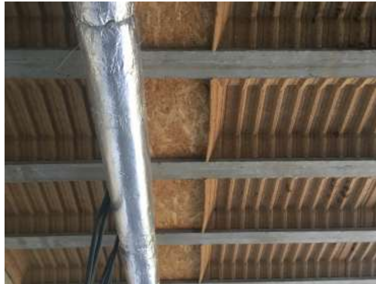
Détail des entrevous au droit des cloisons
