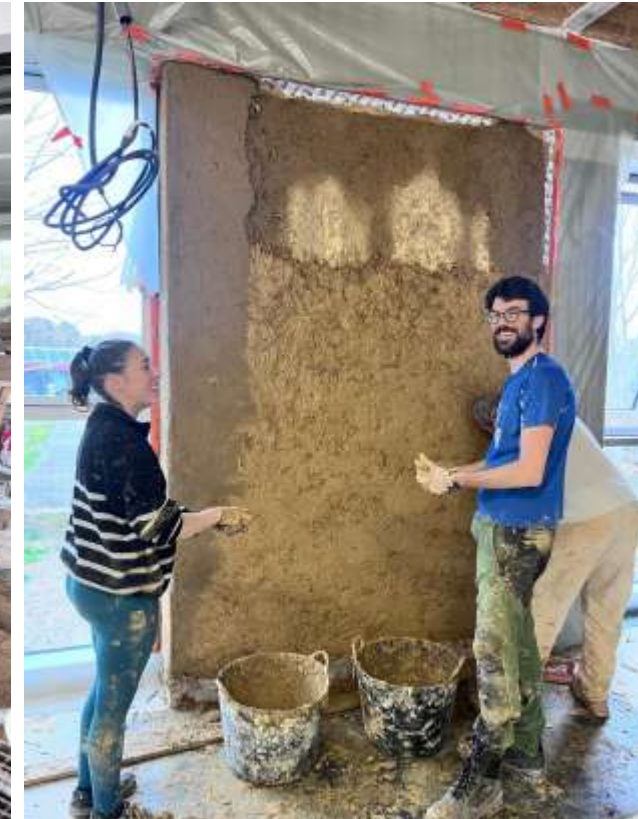
2 ème passe Corps d'enduit
