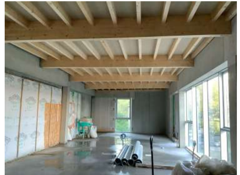
Charpente bois et panneaux de couverture CTBH
