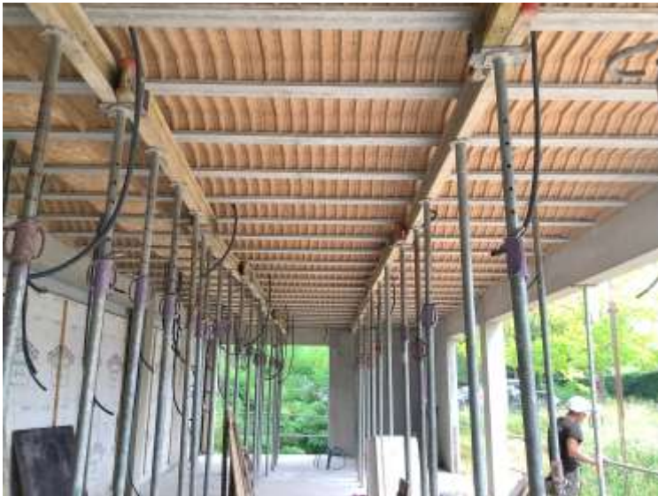
Entrevous bois avec poutrelles béton et dalle de compression
