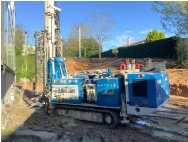
Mise en œuvre des pieux
